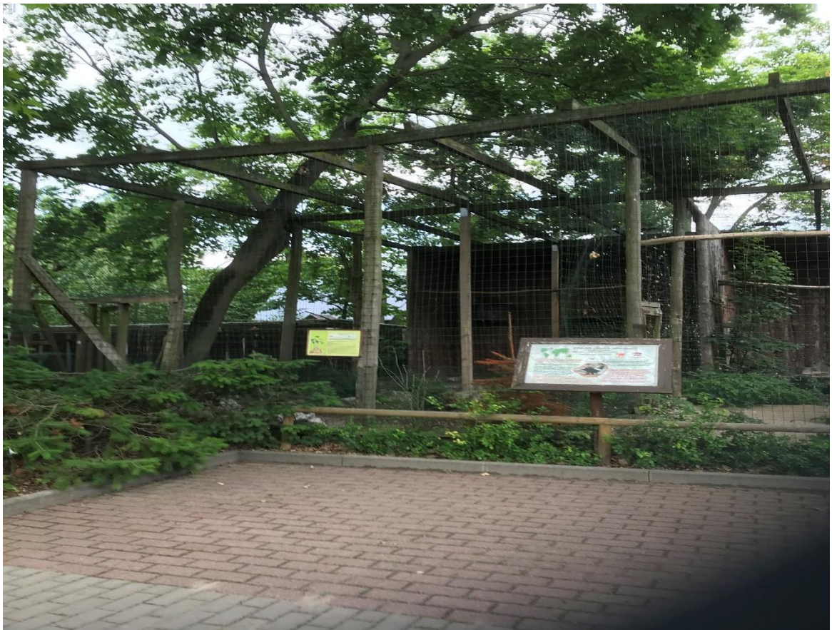
Fot. 3. Wyboczone , powypychane siatki na ścianach wolier , belki, słupy pokryte mchem co świadczy o dużym zawilgoceniu drewna – stan techniczny zły.
