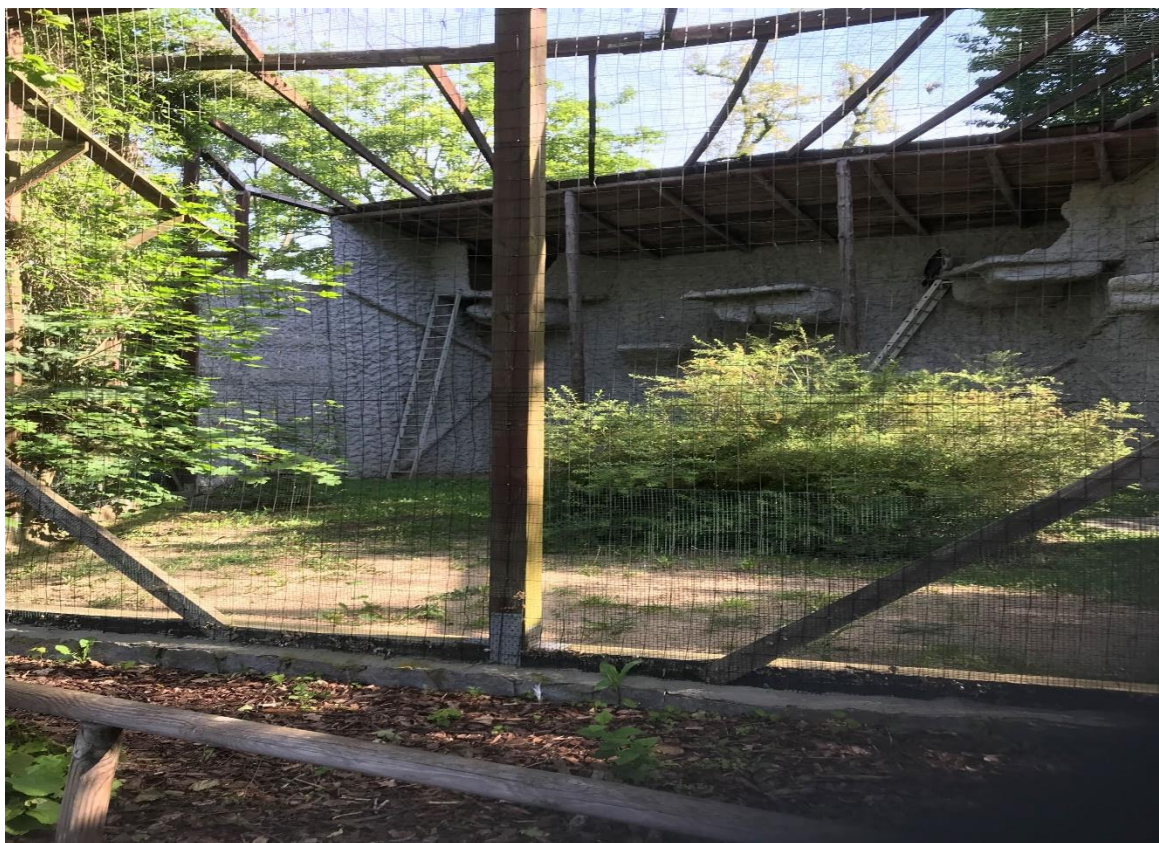
Fot. 5. Nieprawidłowe połączenia na belkach dachu i ścian wolier- stan techniczny zły.
